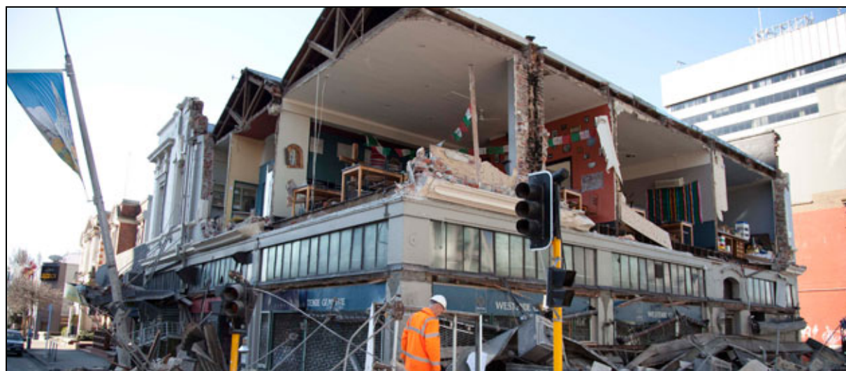
Dégâts occasionnés par le séisme à Christchurch (Photo : REUTERS)
