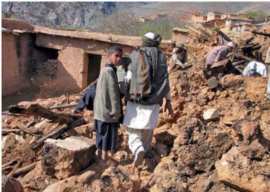
Dégâts observés suite au séisme afghan du 18 avril 2010 (photo : REUTERS)
