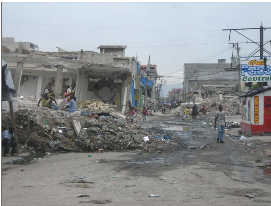
Ruines de bâtiments effondrés dans les rues Haïtiennes (photo : V.Courtray / MEEDDM-DGPR-CCIAPSA)
