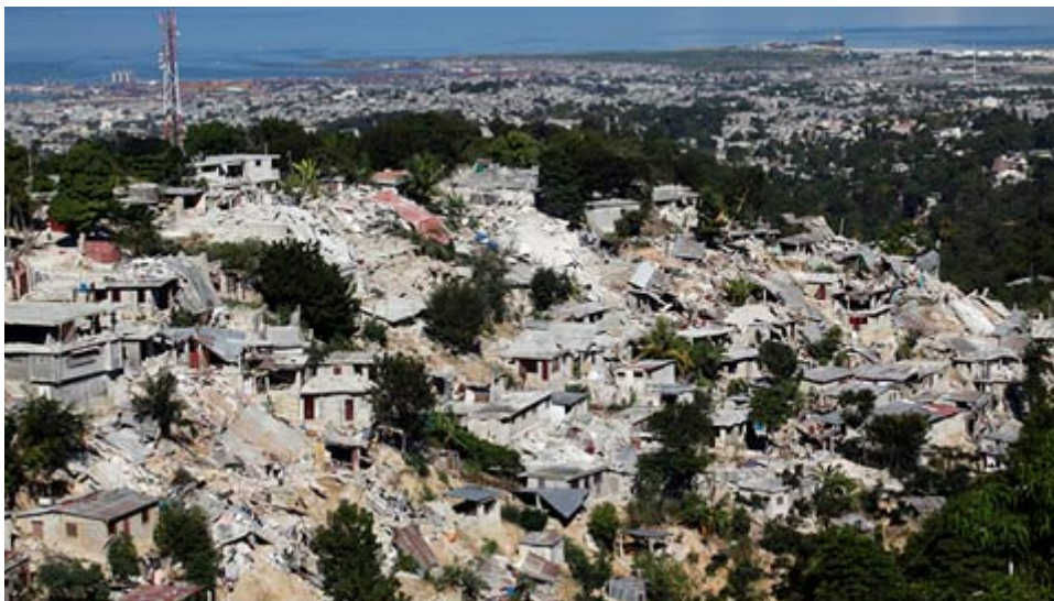
Vue des dégâts causés par le séisme du 12 janvier 2010 (photo : Reuters)
