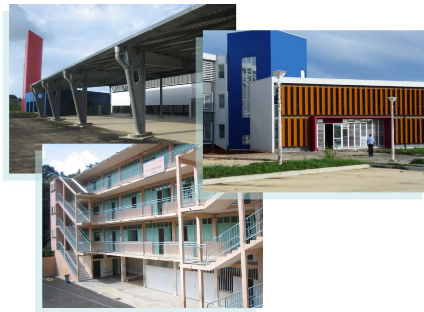
Les bâtiments de l'Etat-major du SDIS Guadeloupe aux Abymes (photos du haut) et de l'école primaire de Citron à Fort-de-France (photo du bas), bénéficient de l'action de confortement/reconstruction
