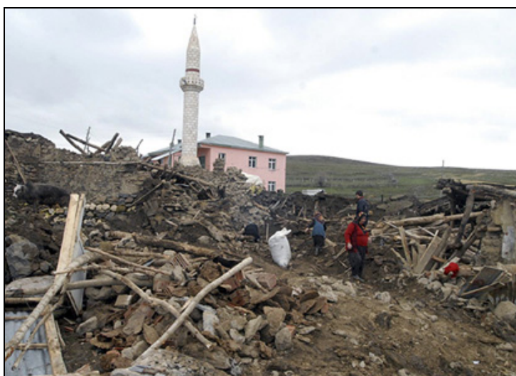
Effondrement de maisons en pisé suite au séisme turc du 8 mars 2010 (photo : REUTERS)
