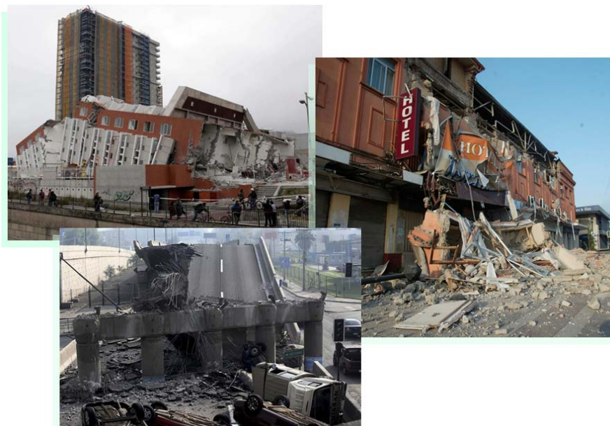
Dommages induits par le séisme chilien du 27 février 2010 (photos : AFP/REUTERS)
