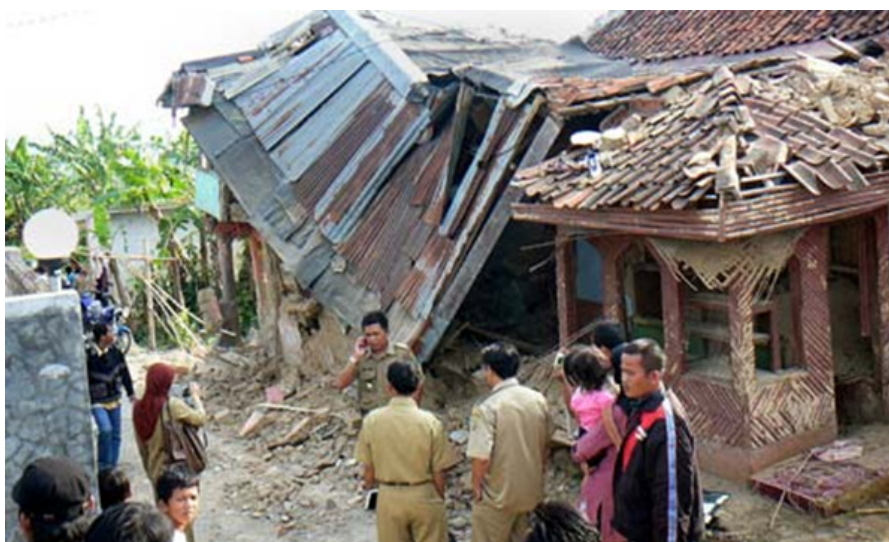
Effondrement d'une maison dans la ville de Sukabumi (Ouest de l'île de Java) suite au séisme du 2 septembre 2009 (photo : STR/AFP/Getty Images)
