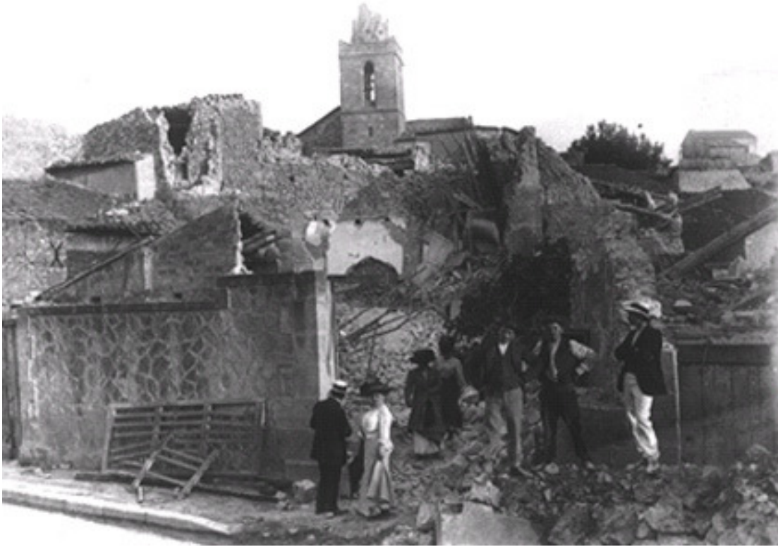
Dégâts observés suite au séisme de Lambesc (Provence) le 11 juin 1909 (source : archives du CEREGE)
