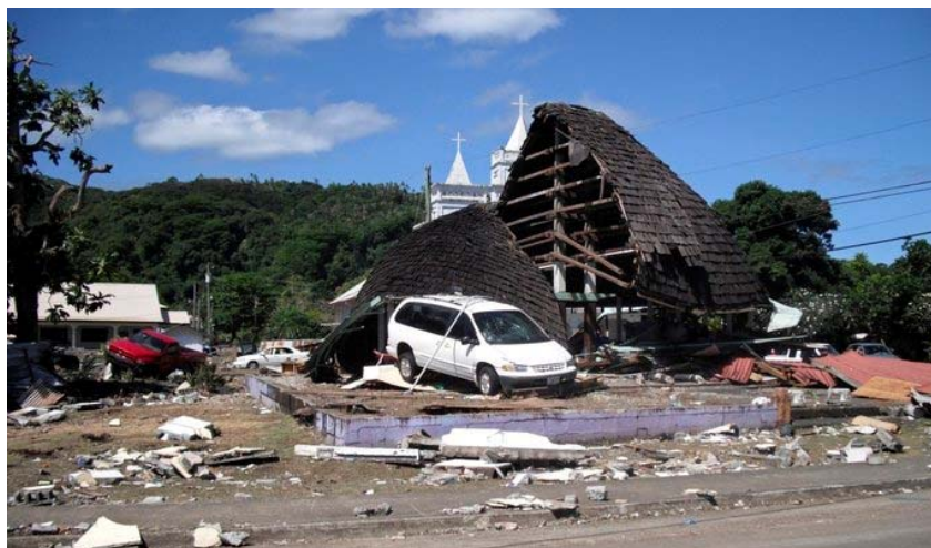
Dégâts observés suite au tsunami qui a frappé l'archipel des Samoa (cliché REUTERS)
