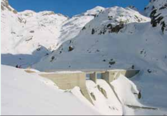
Barrage de La Foue - Alpes-Maritimes - sous la neige (DREIE, J.-C. Puge)
