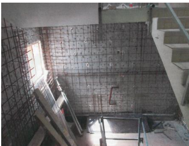
Voile existant renforcé par un double mur en béton armé
