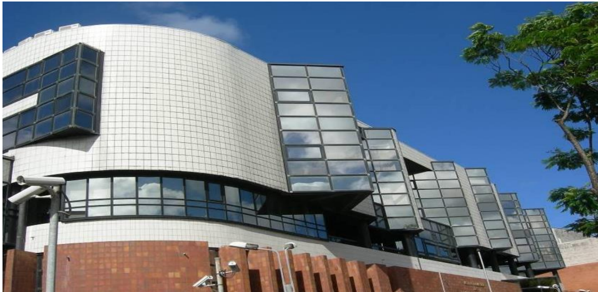
Vue du bâtiment avant renforcement
