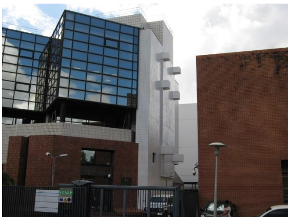
Bâtiment après renforcement – ancrage des câbles de précontrainte
