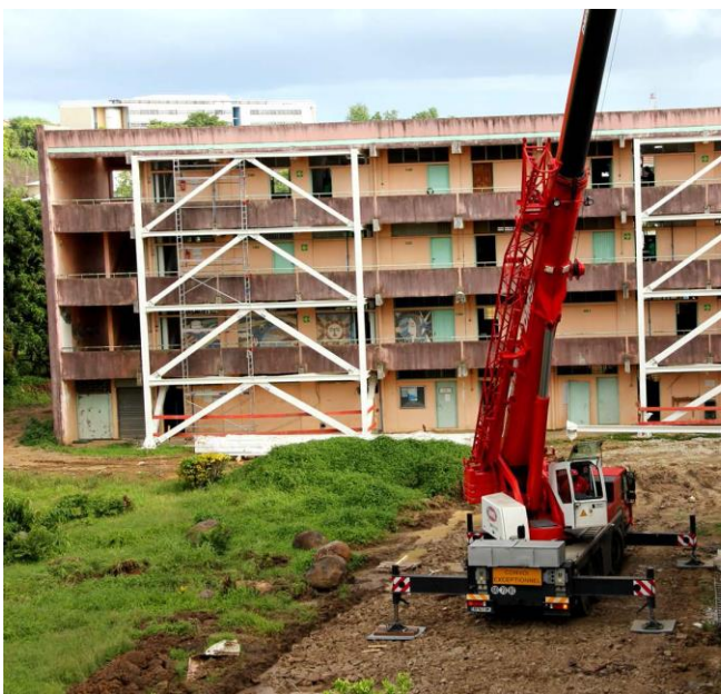
Bâtiment renforcé – vue en élévation
