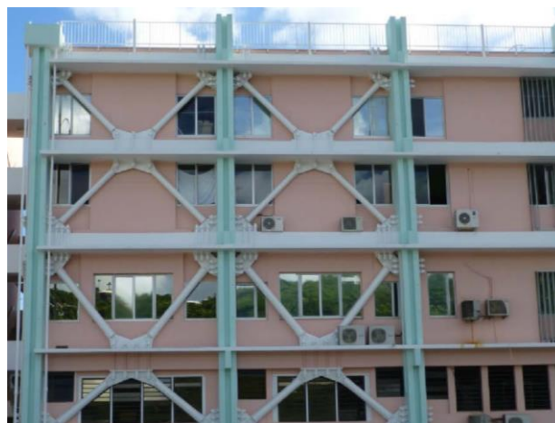
Bâtiment renforcé – treillis mixte
