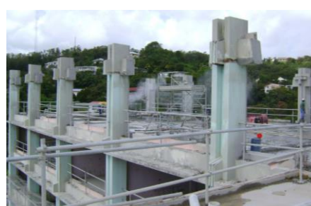
Démolition des étages supérieurs des blocs B et C (du 5 au 8 ème étage)
