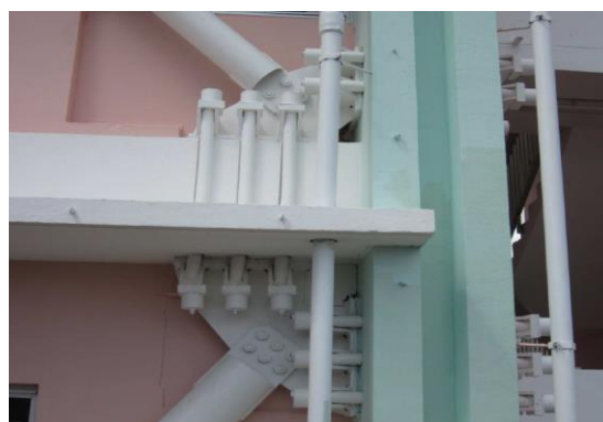
Détail de la liaison – treillis mixte
