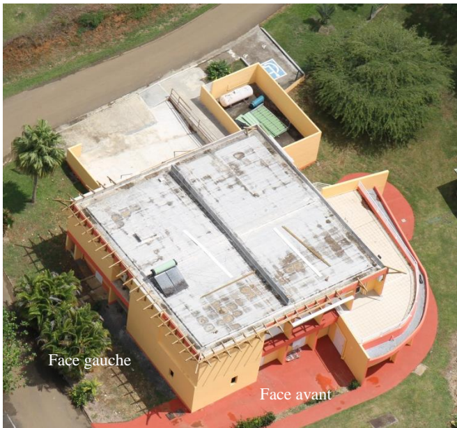
Vue globale du bâtiment après renforcement
