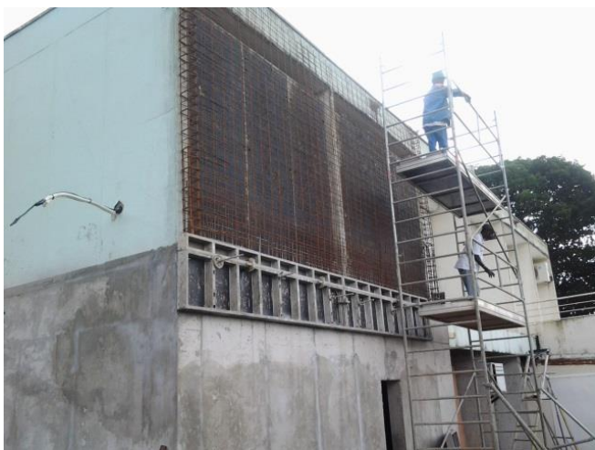
Création des voiles béton armé : voile béton armé du RDJ déjà coulé, mise en place du ferrailage du voile RDC
