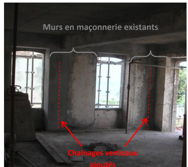
Vue intérieure du bâtiment après ajout des renforcements
