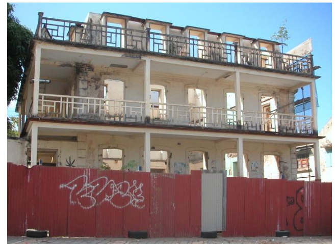
Structure existante de l'école dépourvue de sa toiture et de ses planchers bois – coursives du 20 ème siècle non encore démolies – Photo de la face avant
