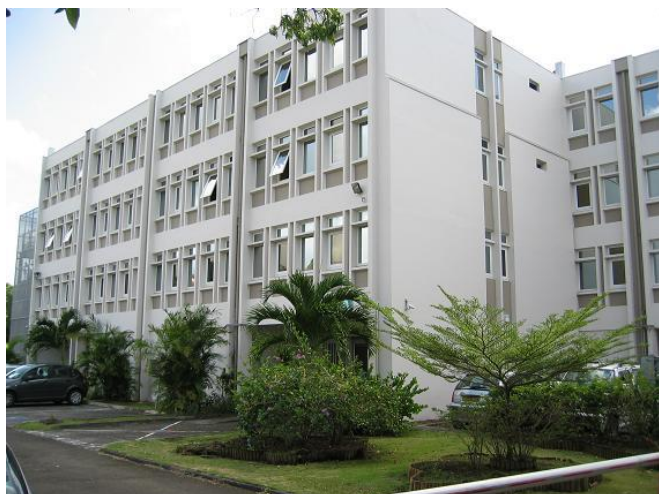
Vue globale du bâtiment après renforcement
