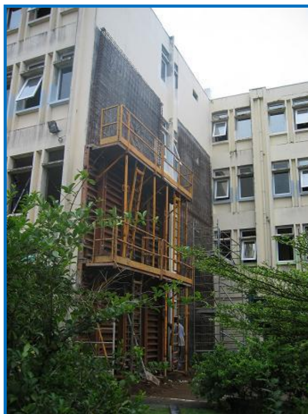
Armatures des parois béton armé ajoutées au niveau d'un des pignons du RDC au R+2
