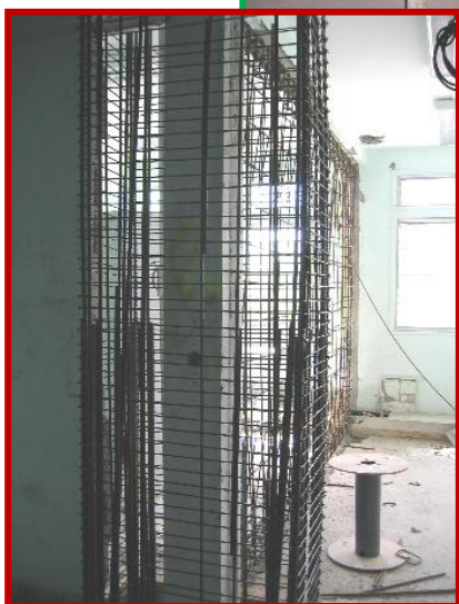
Armatures des voiles intérieurs créés en béton armé et du chemisage des poteaux existants
