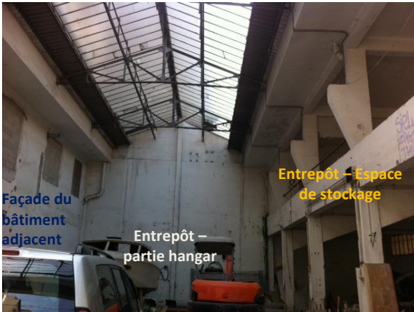
Vue intérieure du bâtiment principal (entrepôt) avant renforcement
