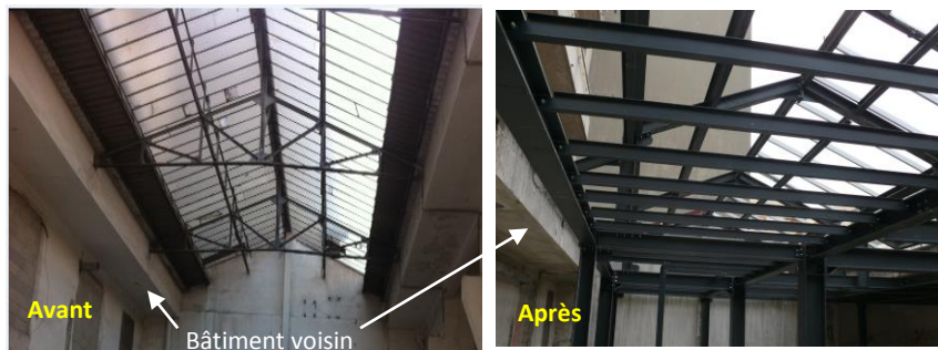
Vue intérieure de l'entrepôt et de la structure treillis métallique : a) avant renforcement, reposant sur le bâtiment voisin et b) après renforcement en appui sur les poteaux métalliques
